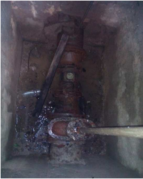
Неисправан стари мерач протока
