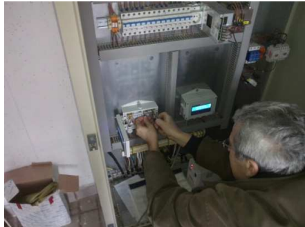
Замена неисправних мерача новим на резервоару Оплецац
