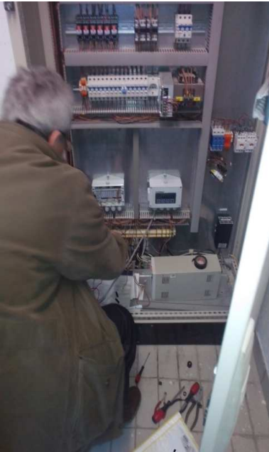
Замена неисправних мерача новим на резервоару Оплецац
